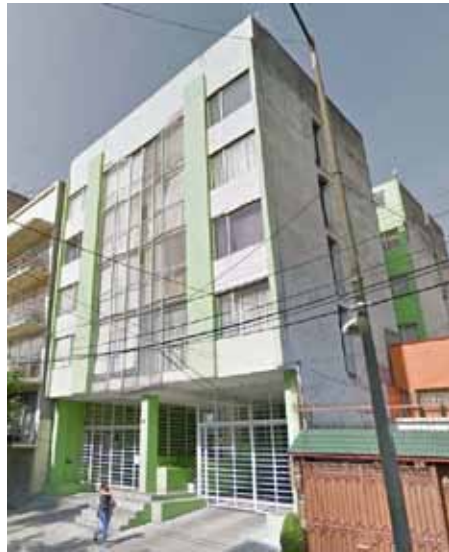
Antes del sismo
