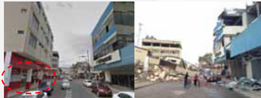
Figura 3: Antes y después, piso flexible, centro de Portoviejo. Fuente: Municipio de Balzar
