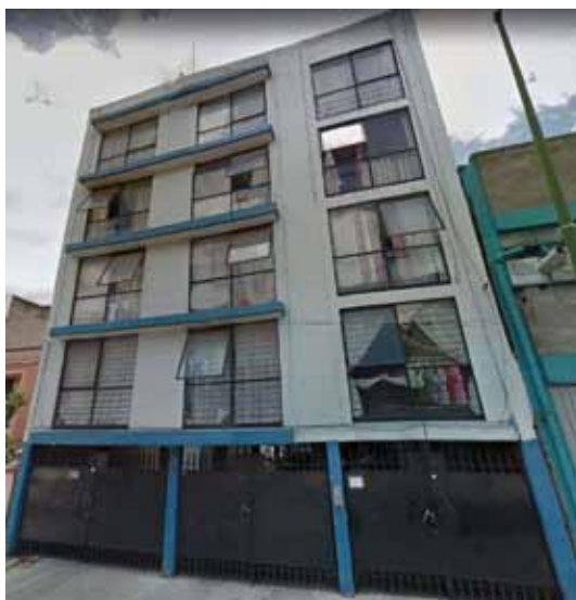
Antes del sismo
